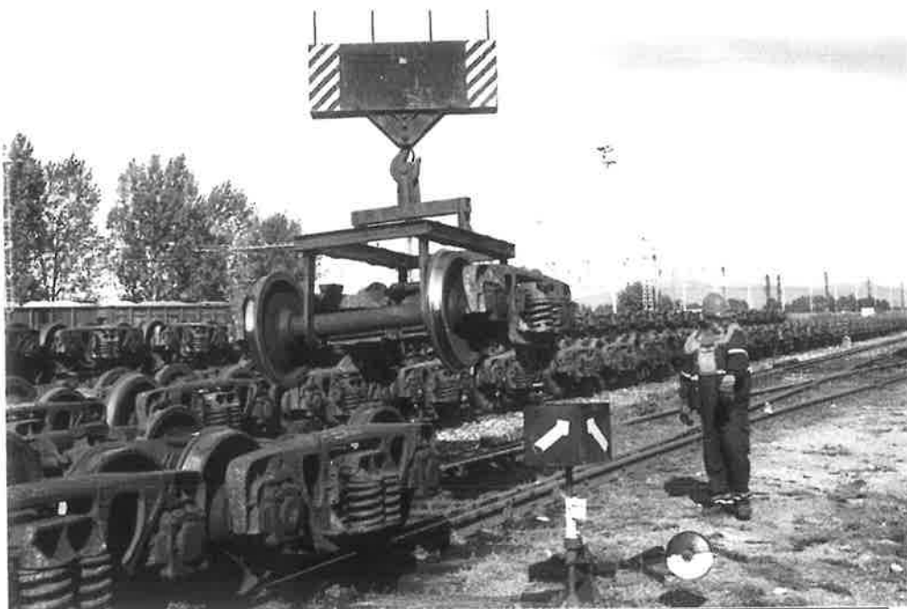
Les bogies à remplacer, ici des écartements larges, sont entraînés par câbles et mis en stock par une grue
